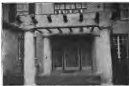
Abb. 44. Unterfahrt aus Eisenbeton, mit Drahtglas eingedeckt, am Landhause in Short Hills. Siehe Cement Age.
